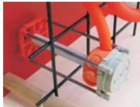
Серия изделий состоит из отдельных компонентов, с помощью которых в зависимости от типа строительства и толщины стен, собираются
