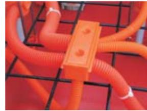
Для электропроводки в бетонных конструкциях электроустановочный материал перед бетонированием нужно подготовить. Комплекты коробок должны быть прикреплены к опалубкам, вся разводка прикреплена с помощью стяжных лент карматуре, вводы в коробки уплотнены герметиком. После застывания бетона и демонтажа опалубки устраняется торец крышки и проводится финальный электромонтаж или монтаж крюка для люстры соответствующей длины.
